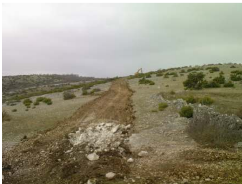
Slika 11. Ravnanje i uređenje površinskog sloja terena prilikom izvođenja pristupnih puteva
