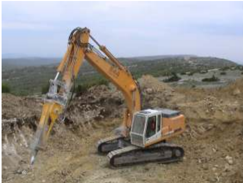
Slika 10. Primjer kopanja temelje bez korištenja eksplozivnih sredstava i udarnog bušenja. Pri izvođenju temelja ne dolazi do nikakvo utjecaja na tlo van samog prostora predviđenoga za temelj
